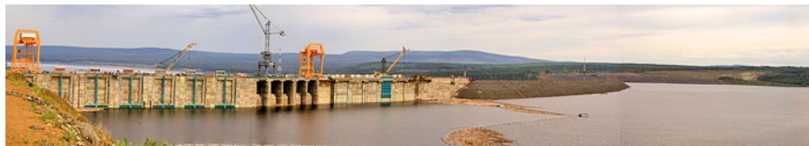
Рис. 1. Нижнее Приангарье. Строительство Богучанской ГЭС. Фотография авторов 2013 г.
