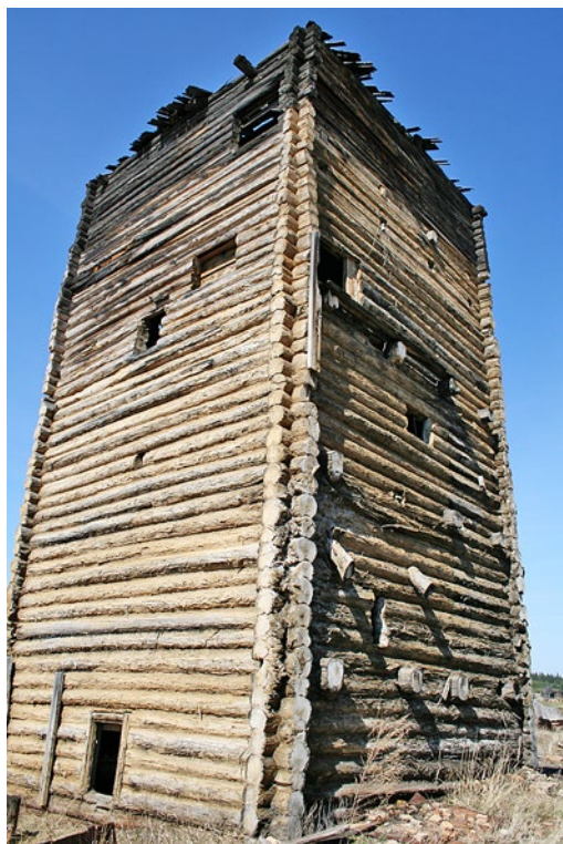
Рис. 6. Троицкий солеваренный завод. Рассолоподъемный колодец. Фотография авторов. 2014 г.
